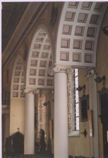
24. Arkada przy ścianie południowej.
