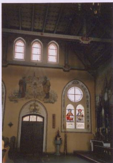
26. Ściana północna transeptu. 27. Strop nad transeptem 28. Ściana zachodnia nawy.
