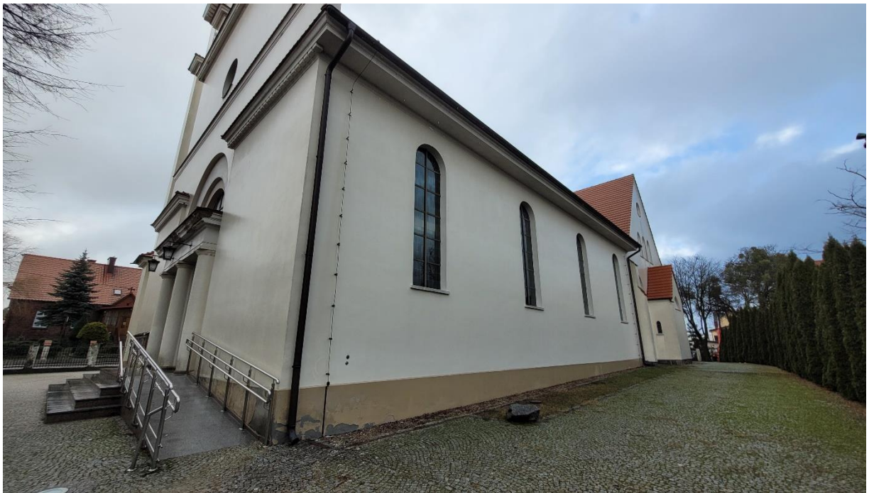
Fot. 4 Cokół do remontu
