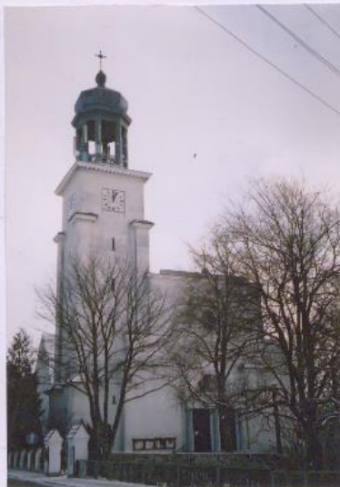
3. Elewacja frontowa – zachodnia. 4. Elewacja tylna – wschodnia. 5. Prezbiterium.
