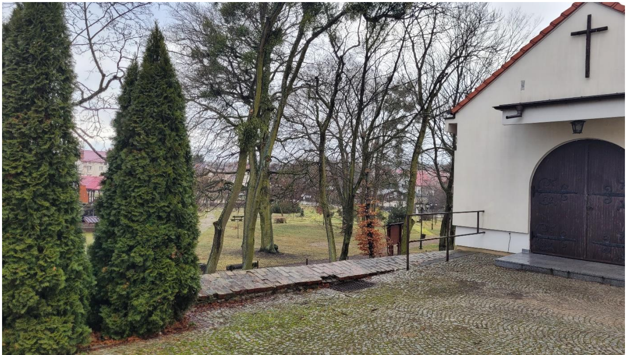
Fot. 7 Mur oporowy przy kościele
