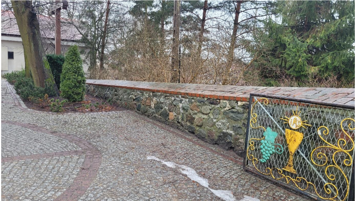
Fot. 5 Mur oporowy przy kościele
