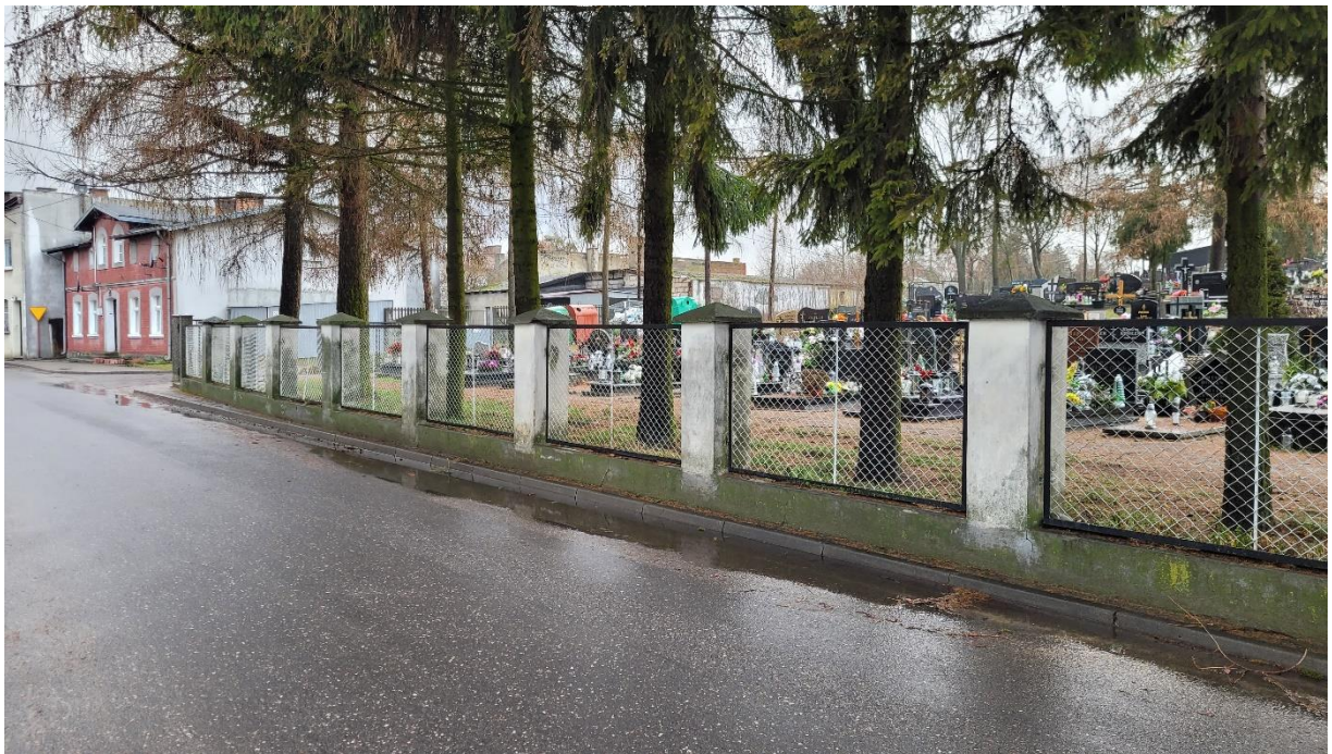
Fot. 8 Ogrodzenie cmentarza
