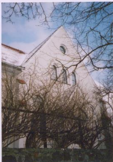
6. Elewacja południowa, nawa poprzeczna.
