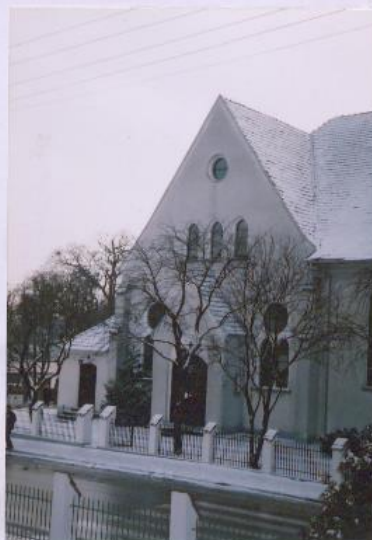
7. Elewacja południowa – nawa poprzeczna.
