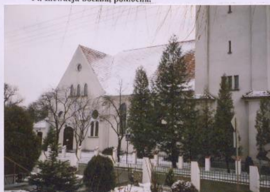
14. Elewacja boczna, północna.
