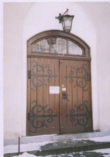
17. Drzwi, transept, elewacja północna.
